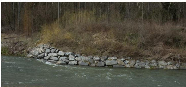
Figure 1: Protection du pied de berge à enlever en rive gauche
