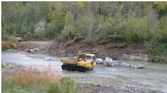
Figure 2: Situation du 07.12.2010, pendant les travaux d'octobre 2010
