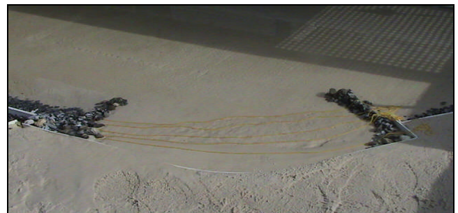
Figure 4: Plage à l'amont du port avec épis de protection
