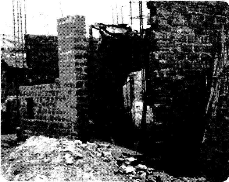
Fig. 1 Le chantier du logement définitif est en même temps le logement provisoire. The construction site is at the same time providing provisory quarters for the family.
