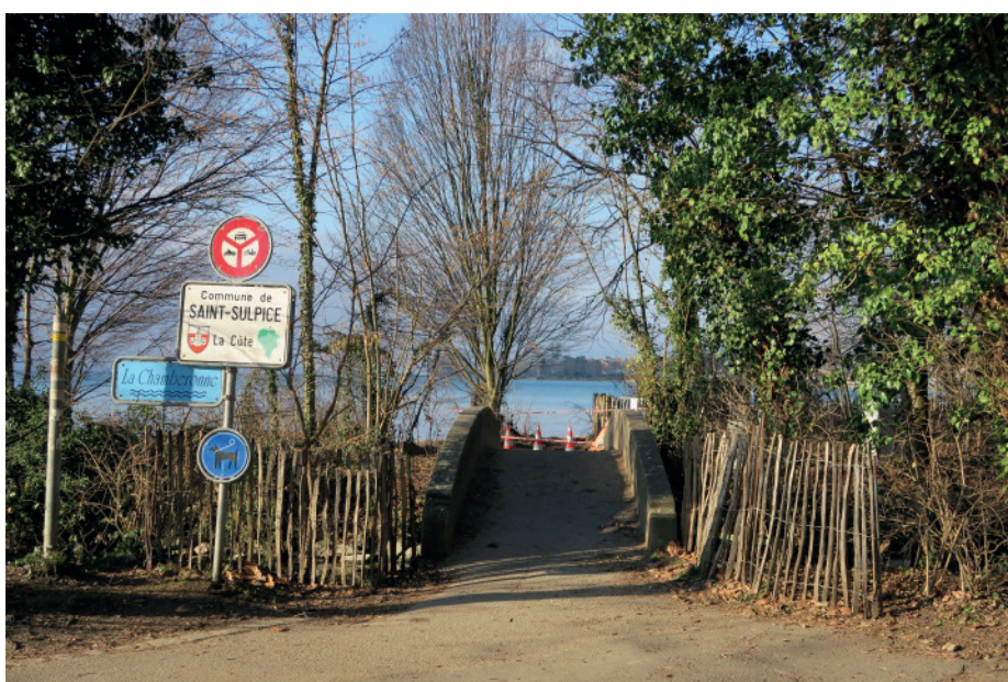
Le pont existant vu depuis la rive Gauche
