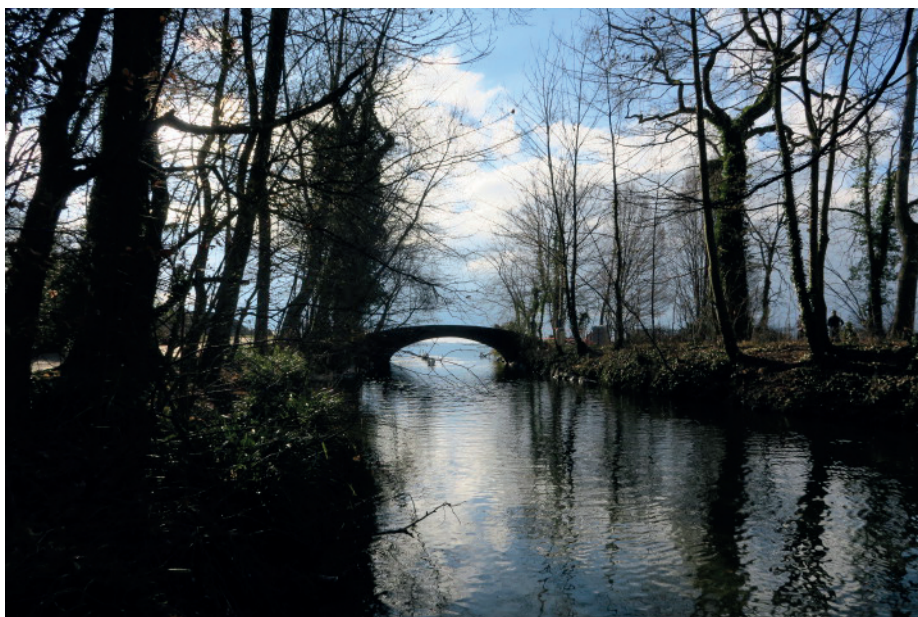
Rive Gauche - Vue de la Chamberonne en direction du pont existant
