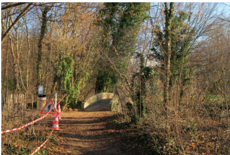
Rive Droite - Vue du pont existant à conserver
