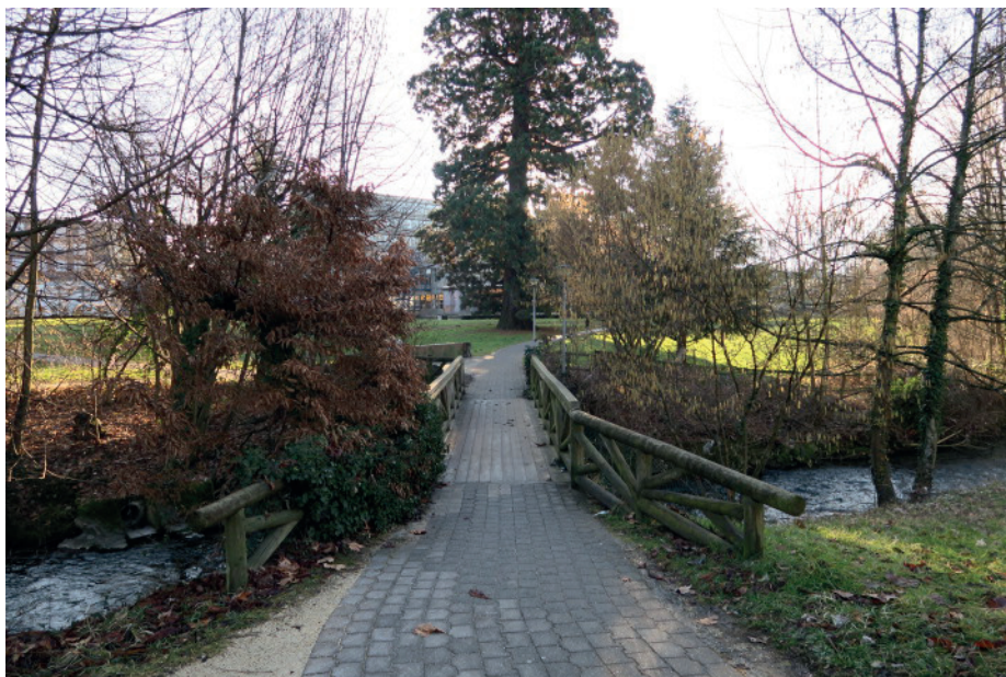
Rive Droite - Vue de la passerelle existante
