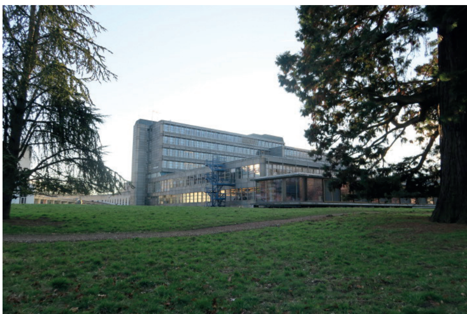
Rive Gauche - Bibliothèque Eouard Fleuret et Bâtiment Internef
