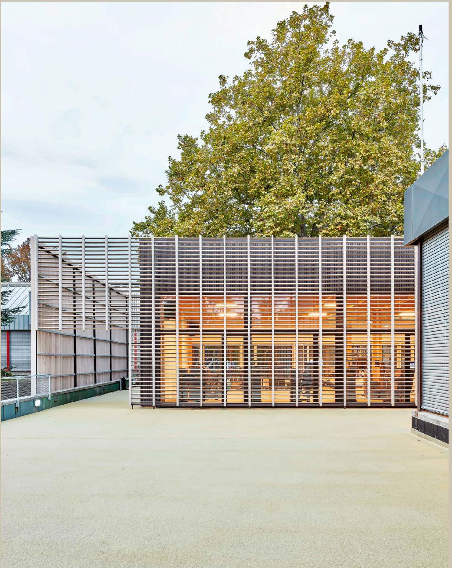
1 An der Südseite des Pavillons sind die Lamellen horizontal angebracht und dienen so dem Sonnenschutz, im Norden mit vertikaler Ausrichtung bilden sie einen Filter zwischen der äusseren Erschliessung und den Sportlern.
