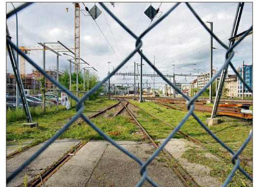
Les friches ferroviaires sont souvent situées au cœur des villes. CHARLES ELLENA
