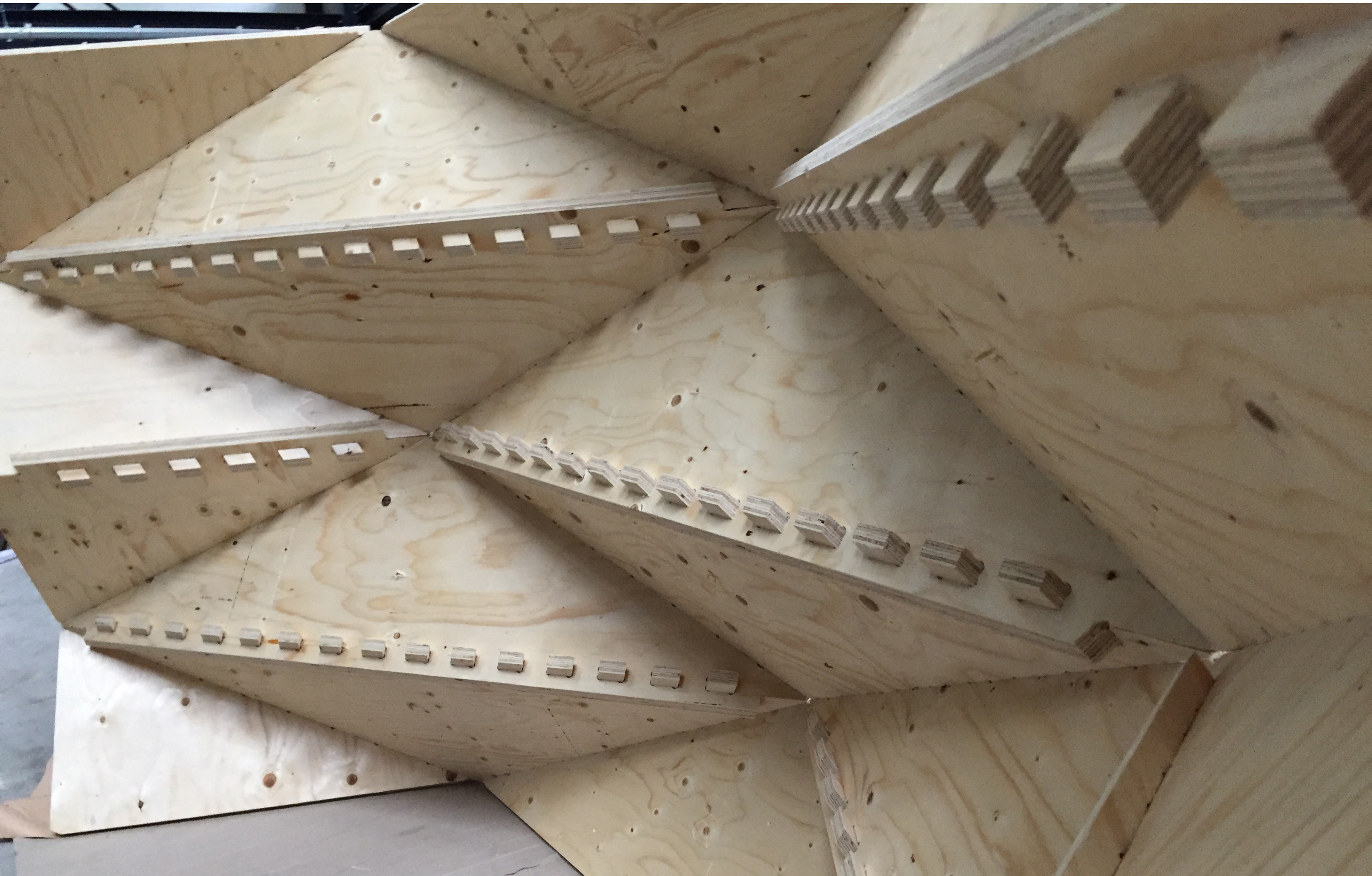
Structure plissée en panneaux en bois stratifié Joint à tenons fermés
