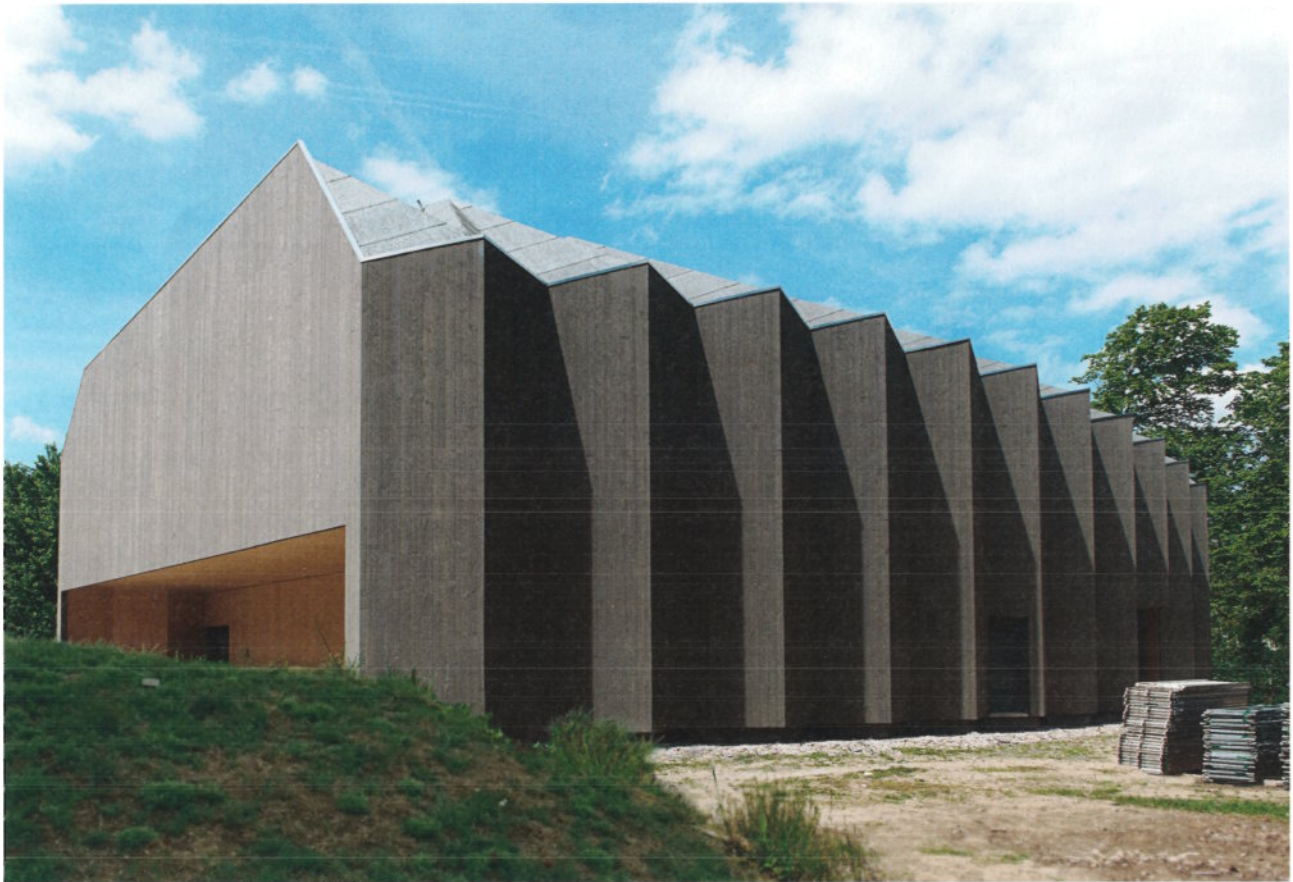
Als Faltwerk konstruierte Binder, zusammengesetzt aus Holzplatten, bilden den 9 m hohen, 28 m langen und 20 m stützenfrei überspannenden Raum des Théâtre de Vidy.
