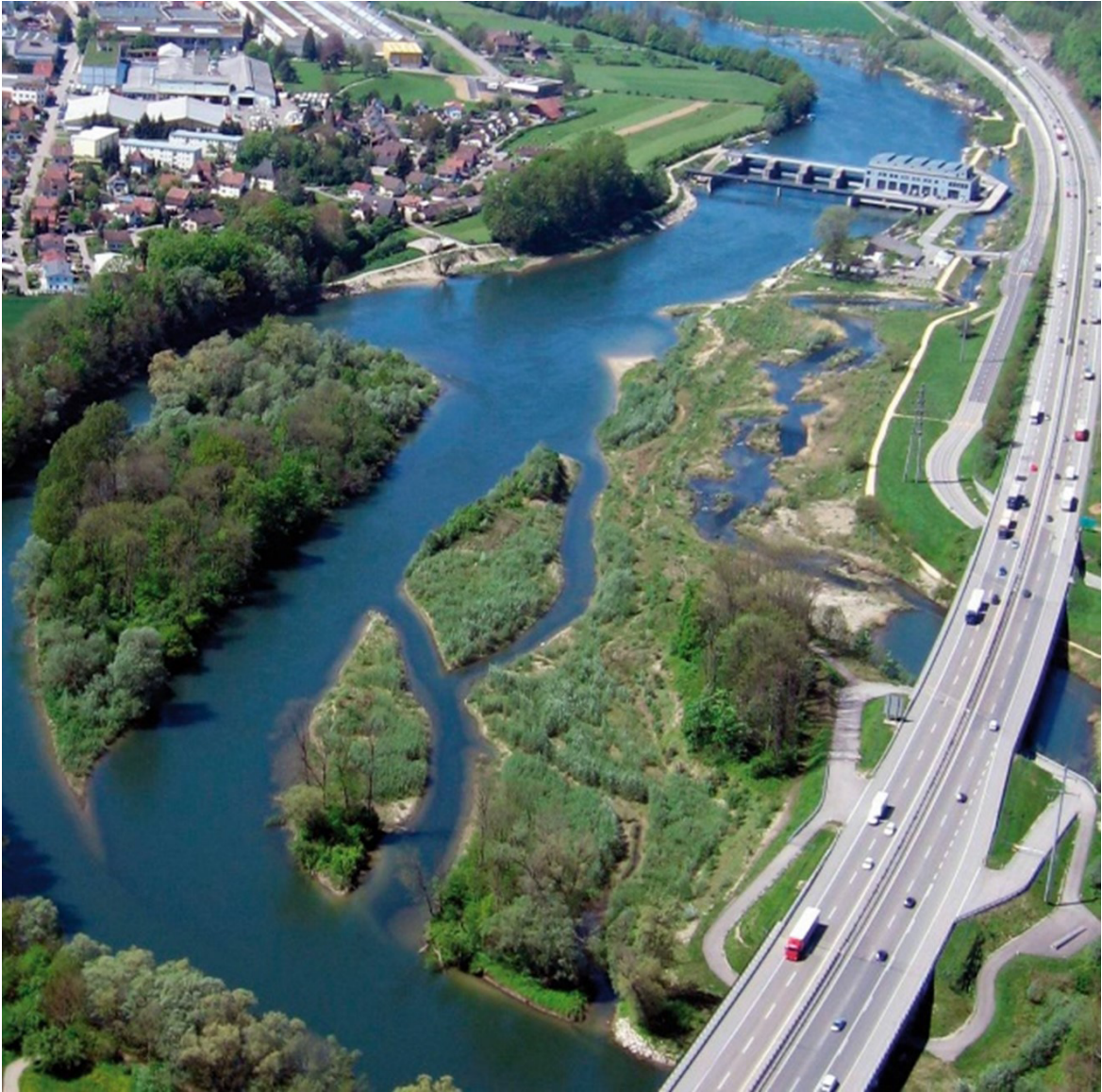
Abbildung 3.9: Wasserkraftwerk Ruppoldingen an der Aare (Foto ATEL - Aare-Tessin AG für Elektrizität, jetzt Alpiq)
