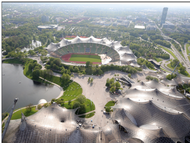
Abbildung 11.7: Dach des Olympiastadions in München. Im Uhrzeigersinn, von oben links: Mathematische Verfahren zur Bestimmung seiner Form und seines Verhaltens, um eine architektonische Form mit „minimalen Flächen“ zu erhalten. Testgelände und -modell. Blick auf den Olympiapark und das Stadion mit seinem 74.800 m 2 grossen Dach. [Schwarz-Weiss-Bilder: Otto-01 et Otto-03 , CC BY-SA 4.0 / Farbbild: Sandro Halank , Wikimedia Commons , CC BY-SA 4.0]
