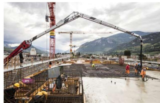
Il en aura fallu du béton! Le radier fait 250 mètres de long pour une épaisseur variant entre 1 m et 1 m 20.
